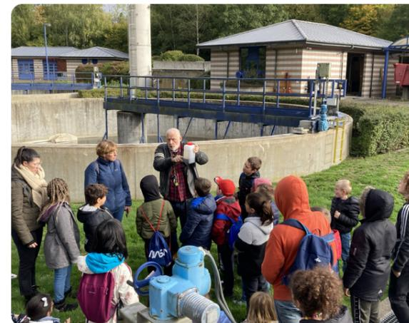
Dans le bassin de clarification, le guide prélève une bouteille du mélange « eau/bactéries ». Dans cet échantillon, les élèves peuvent voir que les bactéries tombent au fond du récipient et que l'eau qui surplombe est bien claire. Ce prélèvement leur permettra également de comprendre ce qu'il se passe dans le bassin suivant, à l'étape de la clarification qui consiste à récupérer l'eau claire, dépolluée, sans les bactéries tombées au fond du bassin. Cet échantillon est ramené en classe.
