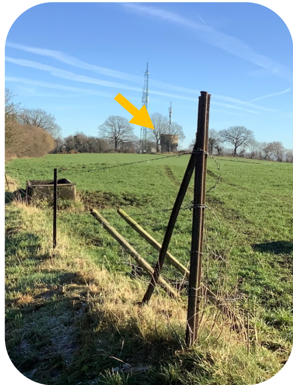
Château d'eau situé à Comblain-au-Pont
